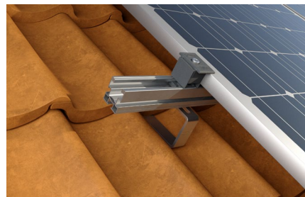
Šikmá střecha s pálenou střešní krytinou
