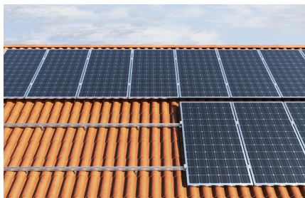
Šikmé střechy s pálenou taškou
