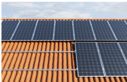
Upevnění na šikmé střechy s pálenou taškou
