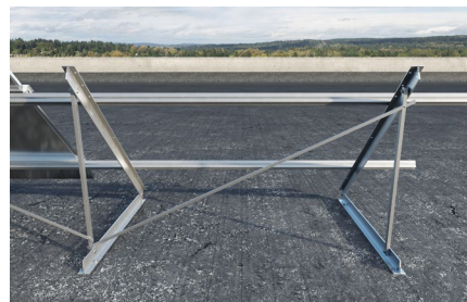
Zpevnění konstrukcí na plochých střechách
