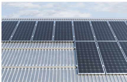
Střecha s trapézovým plechem
