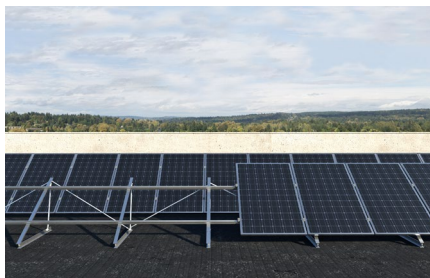
Zpevnění konstrukcí na plochých střechách
