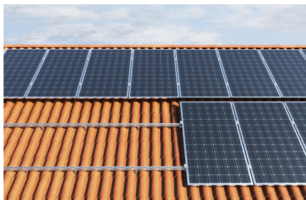
Konstrukce na šikmých střechách
