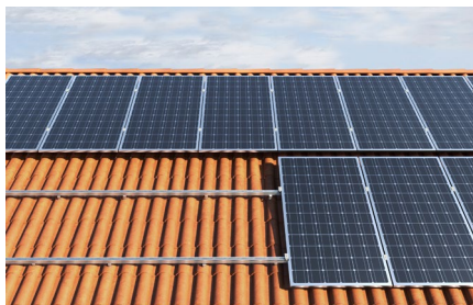
Upevnění FV panelů na šikmou střechu
