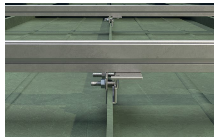
Detail upevnění na falcovaný plech
