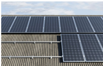
Upevnění na šikmou střechu s vlnitou střešní krytinou
