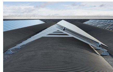
Zvláštní konstrukce na plochých střechách
