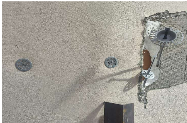
8, Rastr kotvení SXRL-T ve starého ETICS 0,65m x 0,65m
