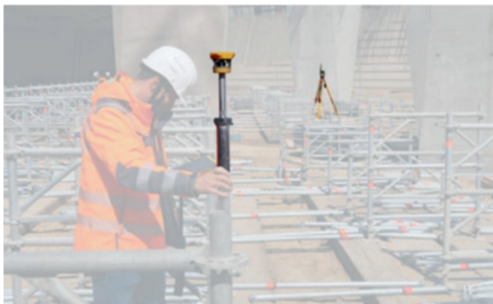
On-site placering af stillads med prisme
