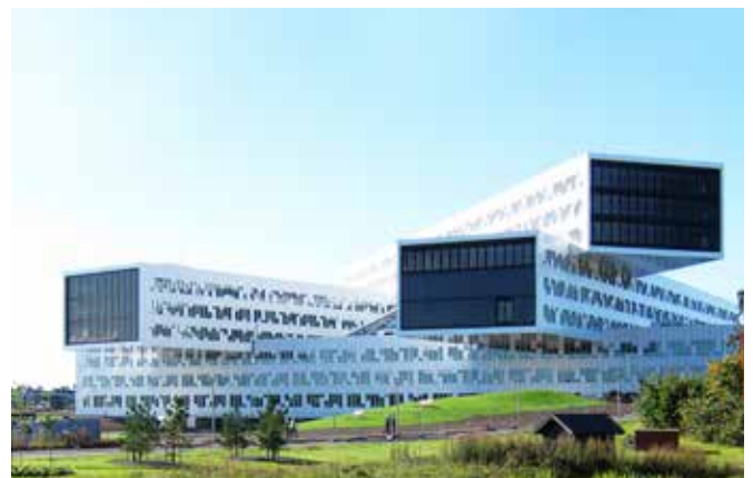
Statoil HQ - Norway - Mini Canal
