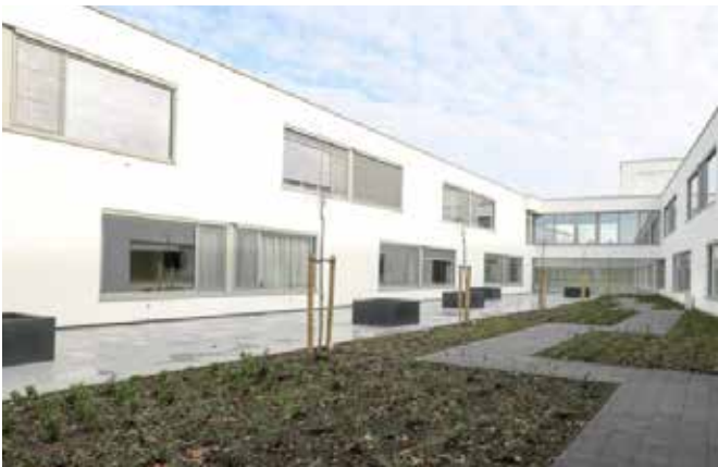
WZC Vinkenbosch - Belgium - Strada & Oxygen
