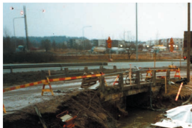
Helsinki, Finland: I rundkørslen på hovedvej Ring 1, er dæklaget kun 400 mm. Weholite SN4 ID 1600 mm, 2 parallelle tunnelrør.
