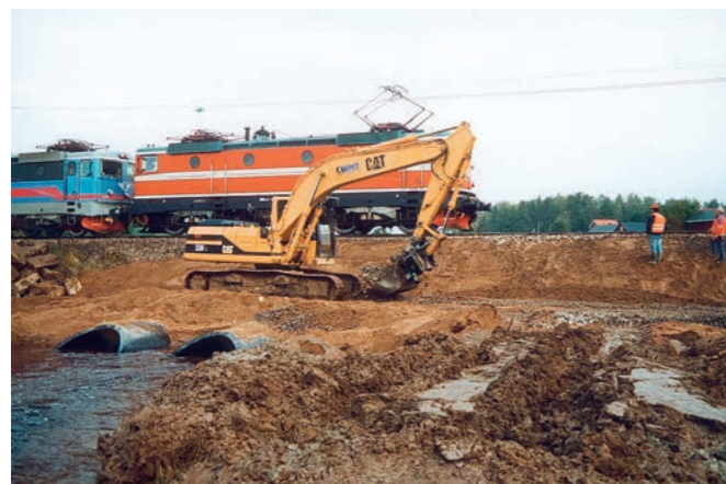
Degerfors, Sverige: Jernbanetunnelrør, Weholite ID 1800 mm, 2x24 m.
